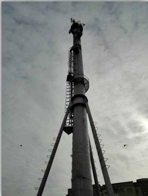
загальний вигляд труби, H=46\text{м}
